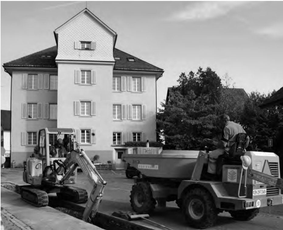
Bauarbeiten für die Erweiterung des Nahwärmeverbunds an der Hans-Haller-Gasse.
