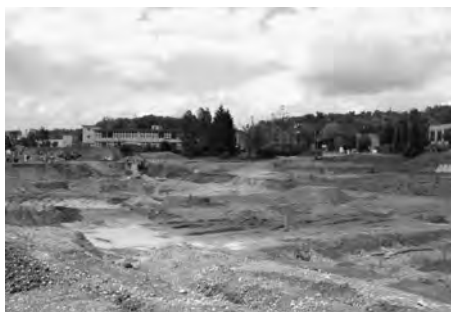
Im Frühling wurden die alten Gebäude der Vetropack AG abgerissen. Ein neues Quartier kann entstehen.
